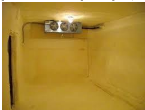
Рис.3– Ізоляція з напленого пінополіуретану
