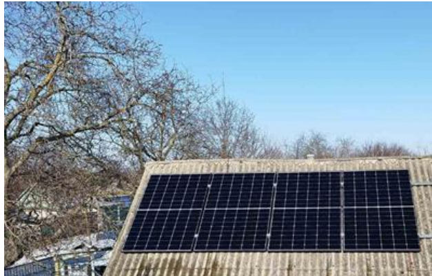
Рисунок 2. Вигляд закріплених сонячних панелей
